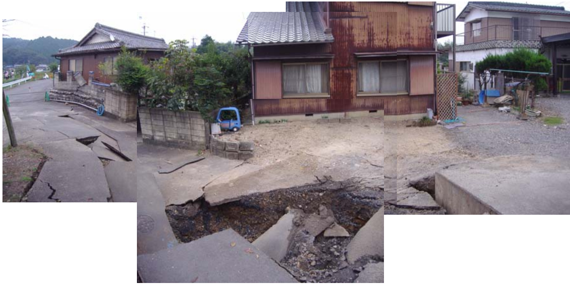
写真一 3 御嵩町顔戸地区の道路および宅地の陥没
