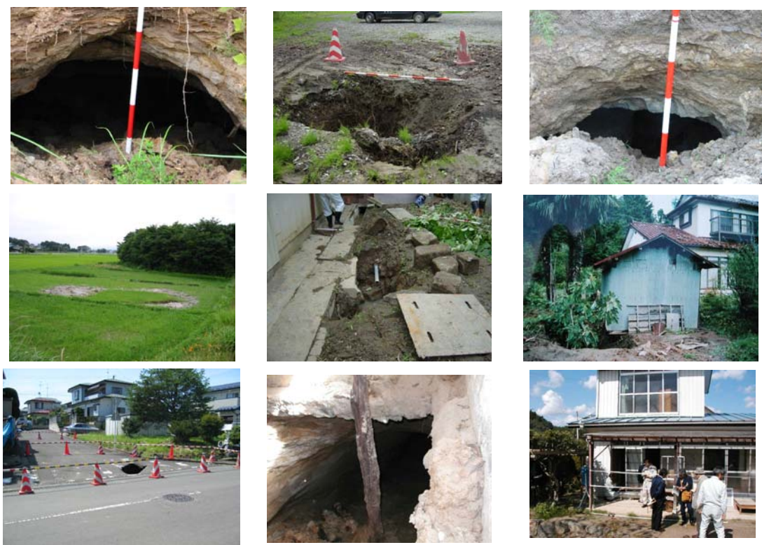
写真一4 宮城県北部地震時の地下空洞による地盤災害
